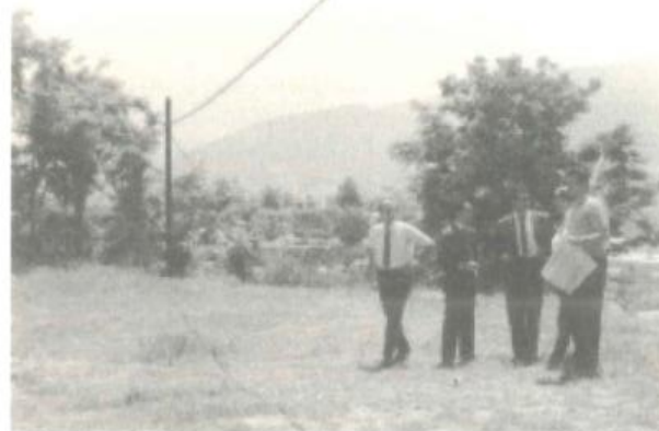
Разгледување на теренот пред почетокот на изградбата на Музејот Reviewing the site before the start of the construction of the Museum
